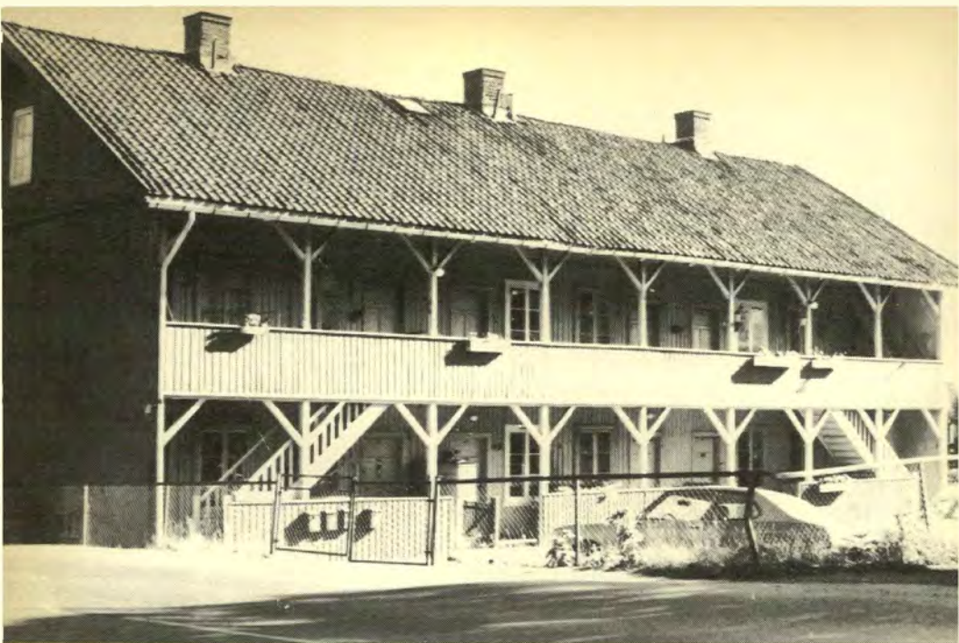
Med det industrielle gjennombrudd omkring 1850 endret dimensjonene karakter. Kaserntypen i to og en halv etasje ble vanlig. Svalgangstype oppført for Mustad fabrikk på Lysaker.
