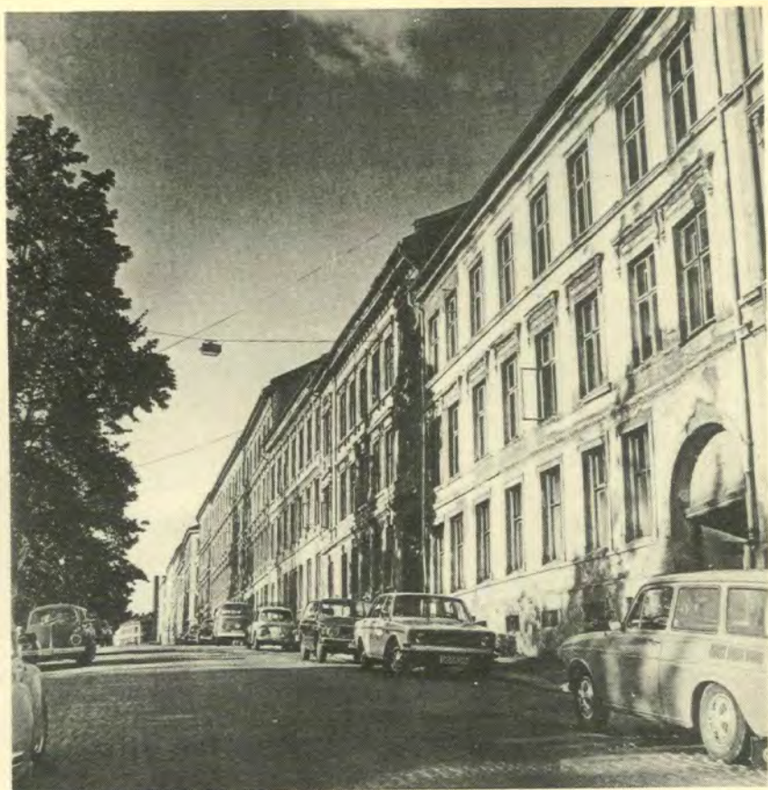
Spekulasjonsbyggeriet medførte at hele bydeler ble oppført som leiegårder i 3 og 4 etasjer. Grünerløkka i Oslo ble likevel ansett som en mønsterbydel, velregulert med parker og gode boliger, selv om gårdsrommene var overutnyttet. Husrekkene i Fossveien, nå revet i forbindelse med Grünerbyggsaneringen. (Foto: W. Murray)
