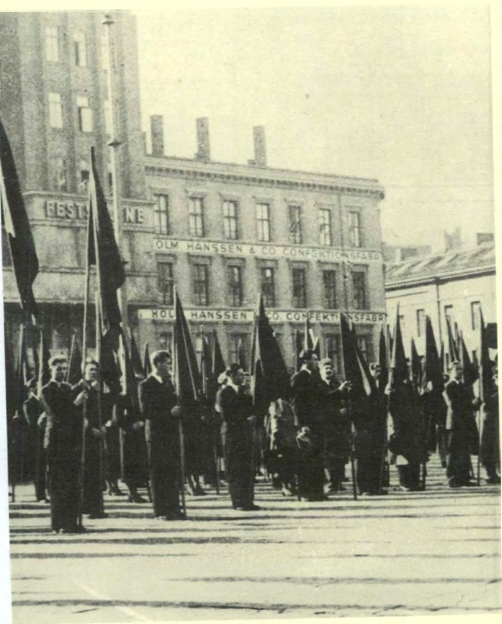
... og i Oslo på arbeiderbevegelsens tradisjonsrike møteplass – Youngstorget. (Foto: Arbeiderbevegelsens Arkiv og Bibliotek)
