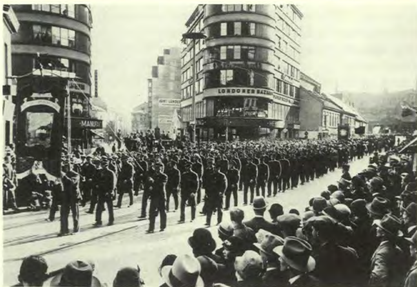
... og Sporveisarbeidernes oppmarsj i Storgata i Oslo i 1934 (Foto: Arbeiderbevegelsens Arkiv og Bibliotek)
