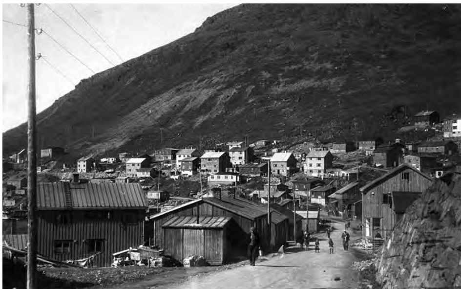
I 1953 bodde fortsatt over 3.000 familier i brakker i Finnmark. Bildet er fra Honningsvåg da gjenreisningen var i gang.
